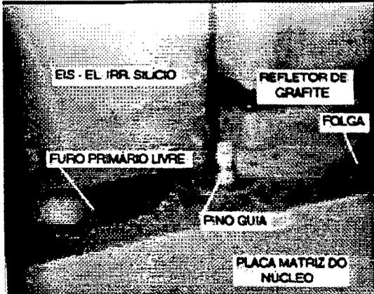
Figura 12 – EIS assentado sobre o pino guia e refletor mal encaixado; com a placa de alumínio especialmente fabricada
