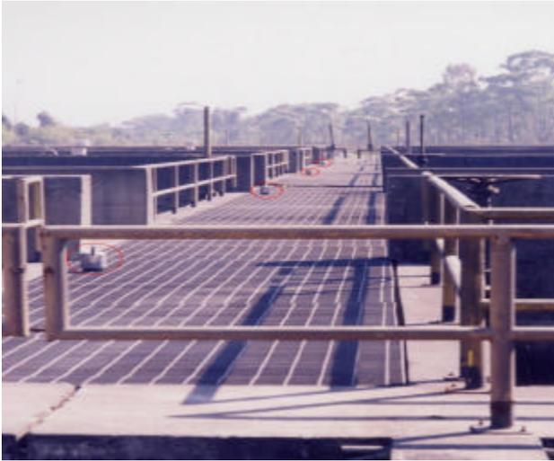
Figura 2. Posicionamento das Blindagens de Chumbo para a Injeção do Traçador na Entrada das Comportas de Alimentação do Tanque A [1]
