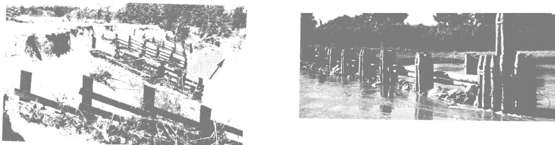
Figura 5 – Proteção Indireta – Espigão permeável, confeccionado troncos, tábuas e bambu
