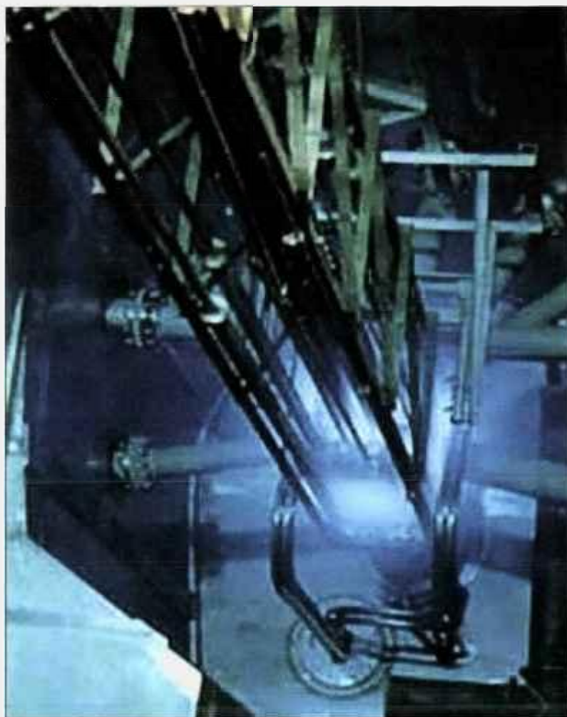
Figura 5. Vista geral do núcleo do reator IEA-R1 (IPEN, 2001).
