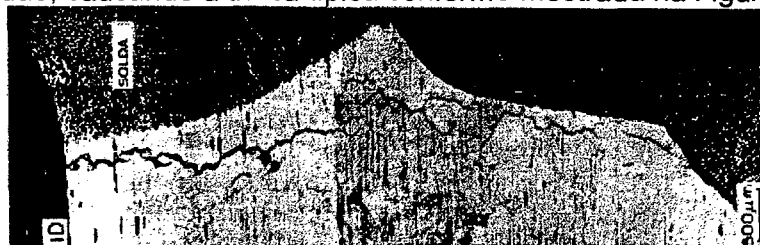
Figura 4. Corte ampliado de trinca por corrosão sob tensão em zona termicamente afetada de solda de aço inoxidável em Usina Termonuclear tipo BWR. [1]
