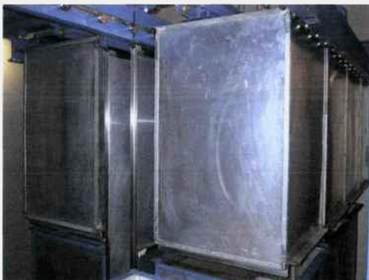
FIGURA 48 - Preenchimento do sistema de transporte pelas 14 caixas em alumínio, em dois níveis, na câmara de irradiação do irradiador multipropósito, sendo 8 caixas com as tampas e mangueiras poliméricas dos geradores de ^{99m}\text{Tc} e 6 caixas com os sacos de 60 litros de maravalha para biotério.
