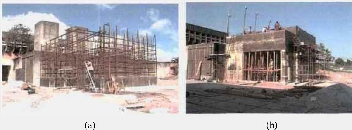
FIGURA 27 – Construção das paredes e lajes em concreto, da câmara de irradiação, do irradiador multipropósito de cobalto-60 tipo compacto, do IPEN-CNEN/SP: (a) armações e (b) formas permanentes em aço carbono.
