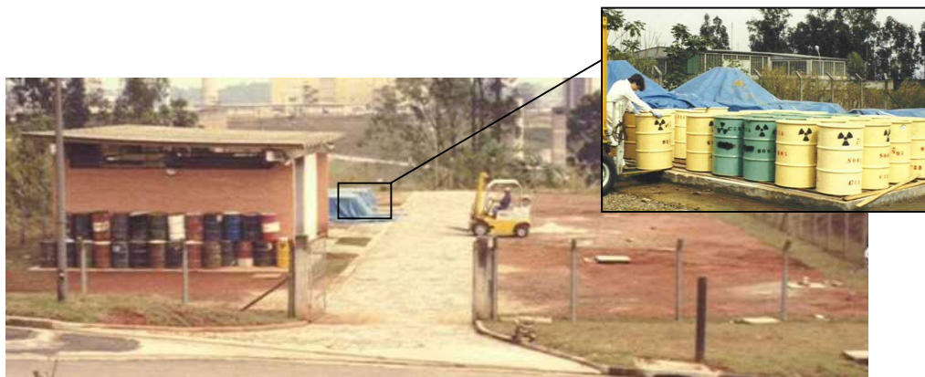
Figura 1. Primeira instalação para tratamento e armazenamento de rejeitos radioativos
