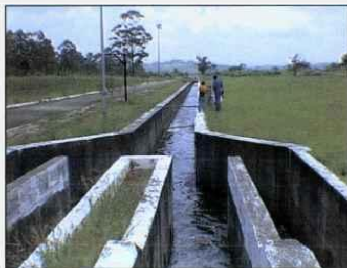
Figura 8 - Foto da saída do efluente final.
