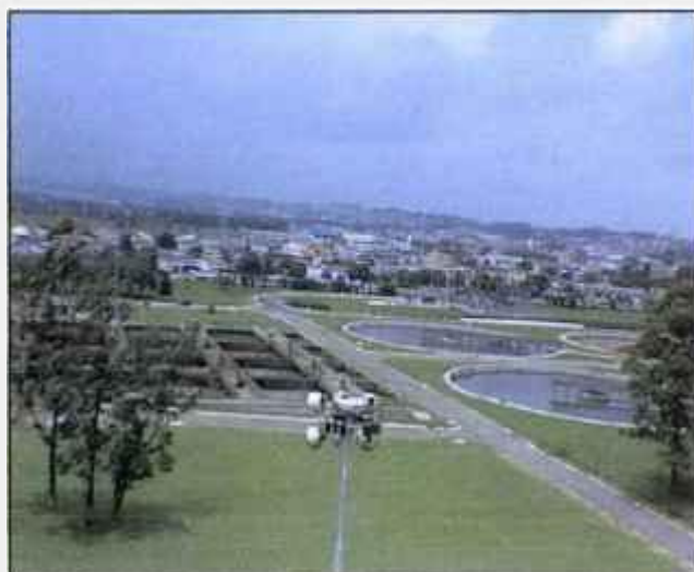
Figura 7 - Vista panorâmica da ETE Suzano.
