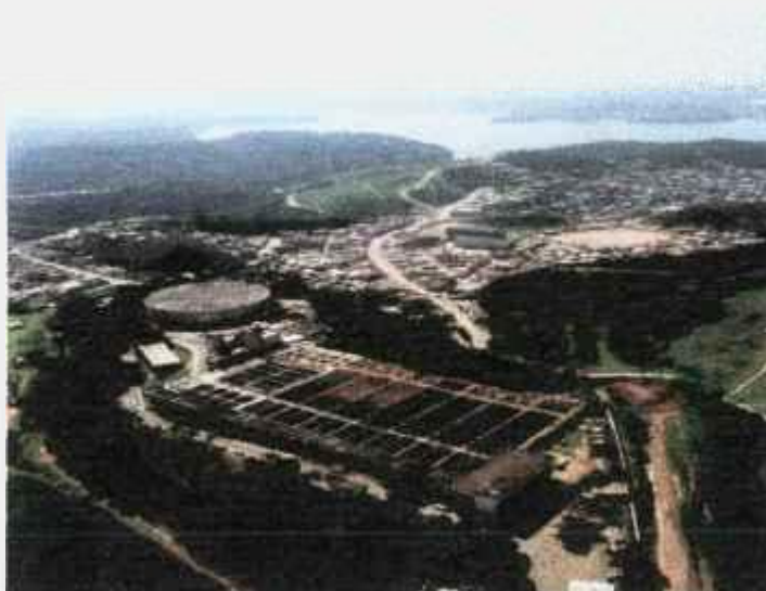
FIGURA 3 - Vista aérea da ETA Rio Grande e manancial ao fundo. Fonte: ETA Rio Grande, 2003.
