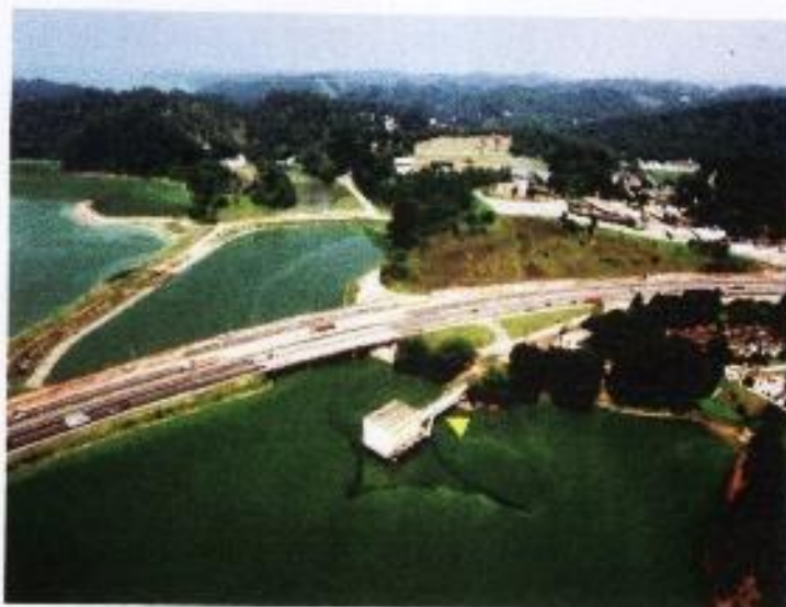
FIGURA 4 - Elevatória Rio Grande de água bruta. Fonte: ETA Rio Grande, 2003.
