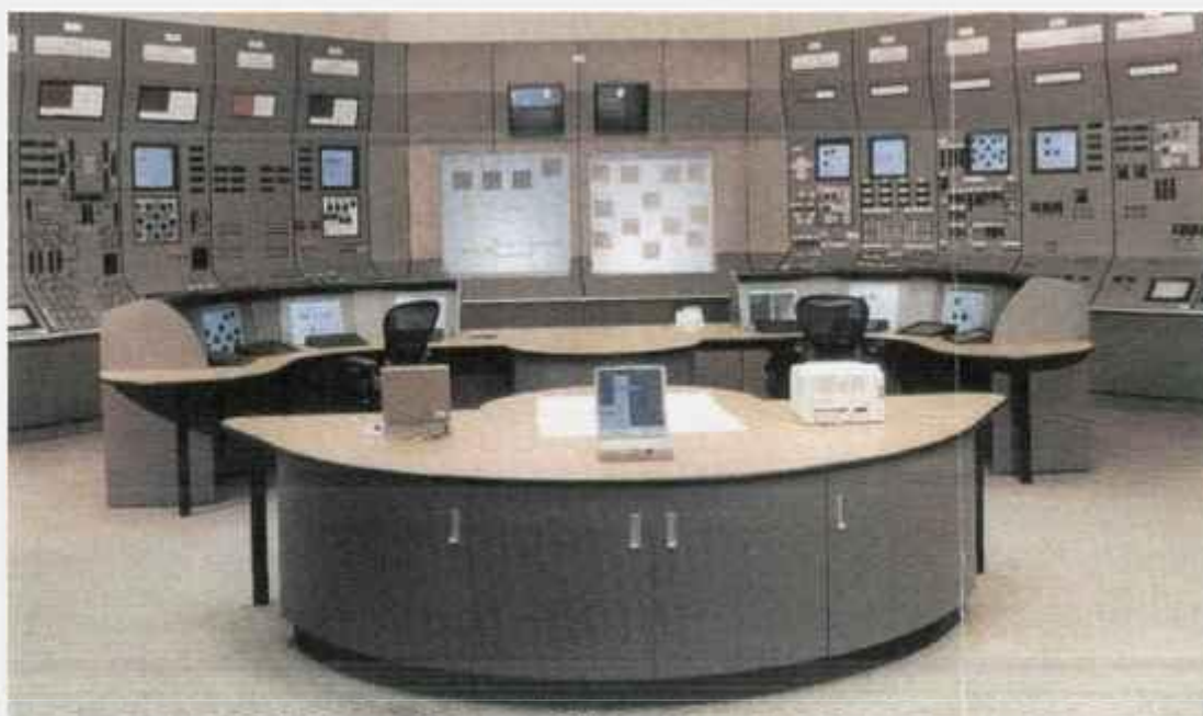
Figura 5 - Sala de Controle de última geração para usinas nucleares, que utilizam reatores do tipo CANDU. [14]
