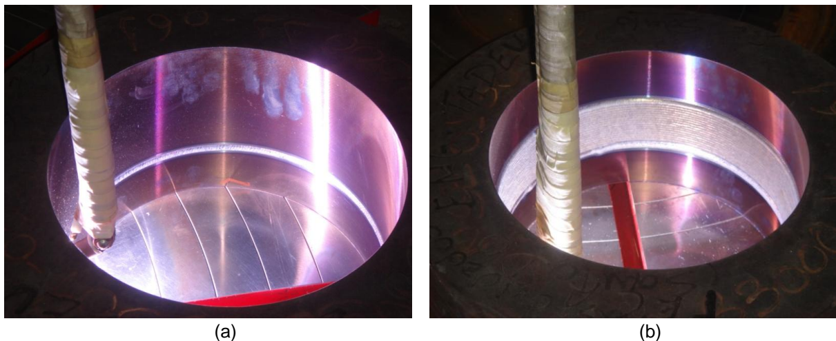
Figura 5: Imagens da realização da soldagem (a) Início da soldagem e (b) detalhe da primeira camada e início da segunda camada.
