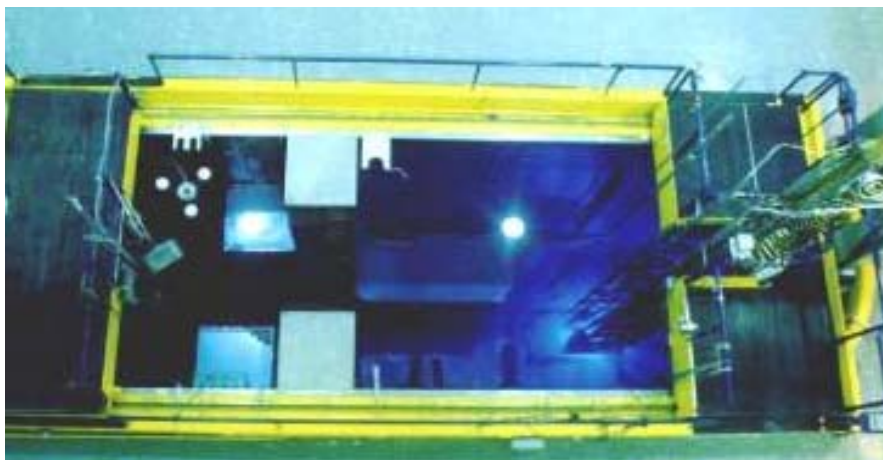
Figura 1. Piscina do reator IEA-R1 com seus dois compartimentos e a treliça de sustentação do núcleo [1]
