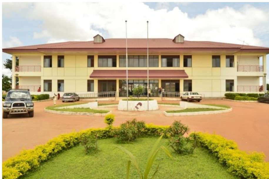
Figura 13 - Imagem frontal do Hospital Militar Principal (HMP)
