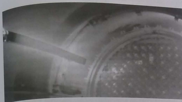
Figura 8.18 – Elemento combustível usado em processo de remoção durante a troca de combustível do núcleo de um reator.
