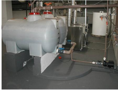
**Figura 4. Tanques de decaimento.**
