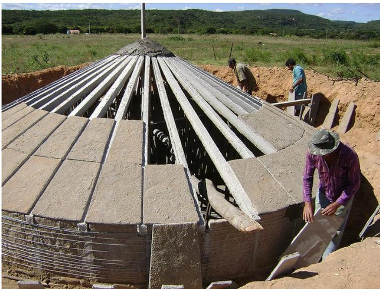
Figura 27: Superior - Cisterna de placas pronta (Fonte: Celso Calheiros). Inferior. Montagem da cisterna de placas pelos moradores (Fonte: conceicaoonline).
