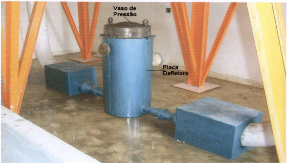
FIGURA 21 - Vista do piso da seção de testes antes da instrumentação do vaso
