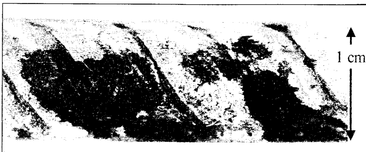
Figura 7.45 – Produtos de corrosão localizada em barra de aço sem proteção.
