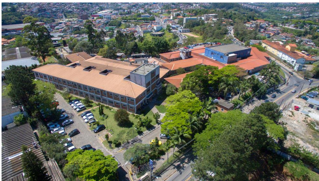
Figura 11 – Vista aérea do Hospital Regional de Cotia (HRC)
