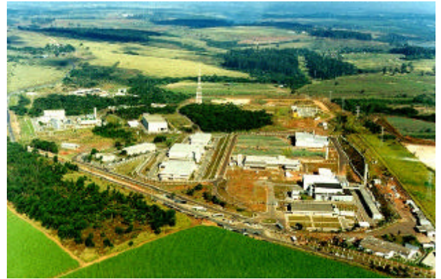
Figura 3. Vista Aérea do CEA.
