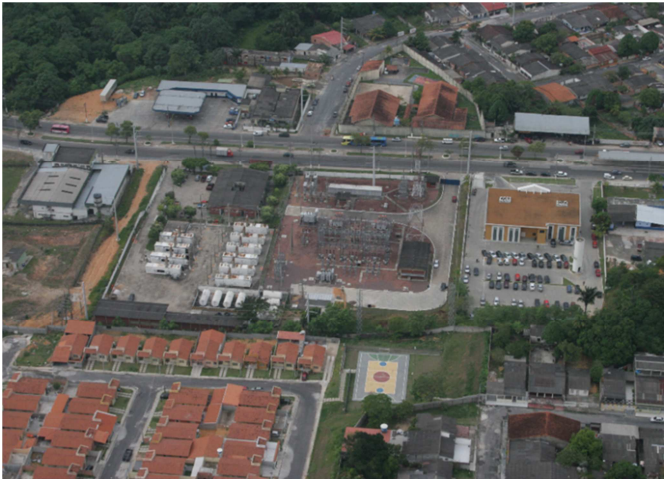
Fig. 3. Vista aérea da subestação Cidade Nova
